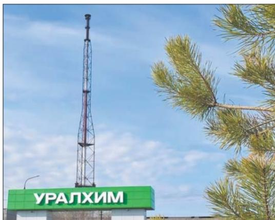
Филиал «ВМУ» АО «ОХК «Уралхим» приступил к ремонту выхлопной трубы СК-48 цеха серной кислоты высотой 180 м. В рамках работ планируется замена металлоконструкции, восстановление антикоррозийной защиты и ремонт системы электроснабжения.
