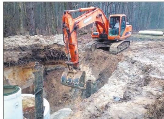
Ко дню своего 50-летия этот объект системы водоотведения двух округов поэтапно получит вторую жизнь. Уже запущена в работу основная часть реконструированной левой ветки канализационного коллектора протяженностью 14 км.
