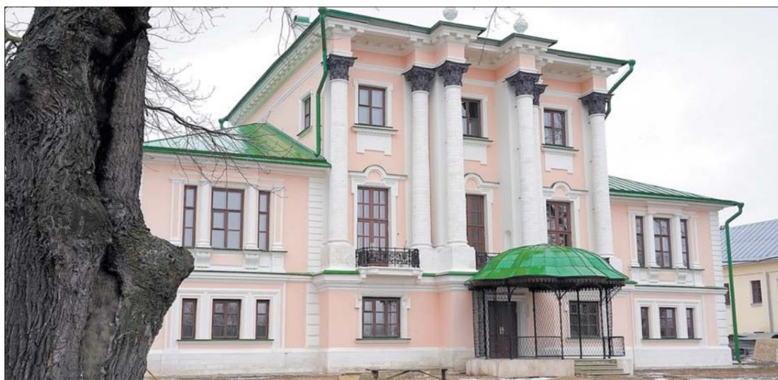
Работы проходили в два этапа: в 2023-м выполнили внешние работы по реконструкции фасада, отмостки, кровельные элементы и внутренние черновые работы. В 2024-м – работы по восстановлению интерьеров. В главном доме восстановили оригинальный цвет стен и элементы лепного декора.
