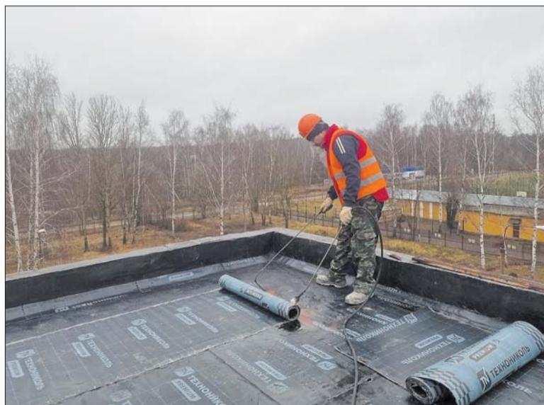
старого покрытия строители приступили к созданию нового многослойного «пирога». Он будет включать утеплитель из минеральной ваты, керамзитовую засыпку и два слоя гидроизоляции для надежной защиты от непогоды.
